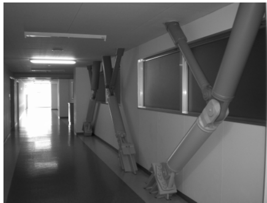
図4: 山一電機 トグル制震装置
