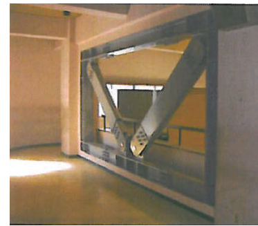
学校体育館の改修例
