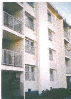
[工事完了後] ALC版でダンパーを カバー
