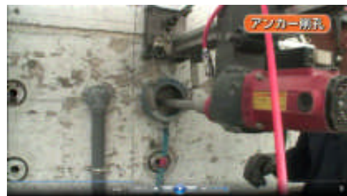
アンカー削孔
